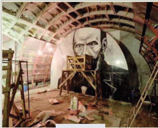
METRO DEDICATA La fermata Dostoevskaja della metro di Mosca, inaugurata nel 2010 [web]
